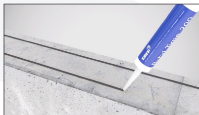
Abdichten der Sockel/Fundament.
