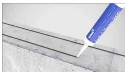
Afdichten tegen plint / fundament.
