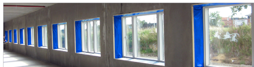
DAFA PE-Rahmenauskleidungsfolie im Zenit Company House (Grünes EU-Bauprogramm).
