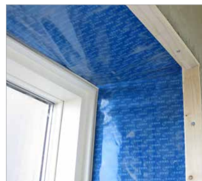
DAFA PE-beschermingsfolie is voorzien van een CE-markering conform EU-norm EN 13984.
