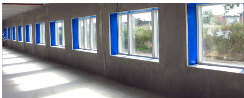
Le film de doublure d'encadrements DAFA PE est utilisé dans la Zenit Company House, qui fait partie du programme de constructions écologiques de l'UE.
