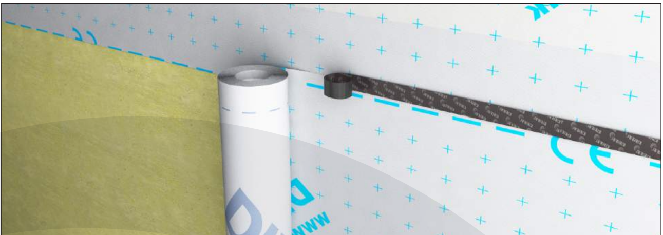
Die Dampfbremse mit Überlappung montieren und mit DAFA Dampfsperrenband abkleben.
